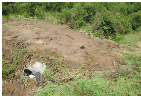
Installation d'un passage pour bétail en PEHD (© Contrat de rivière Ourthe)
